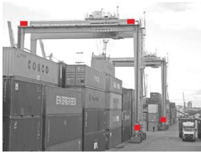
PONT ROULANT - CRANE
